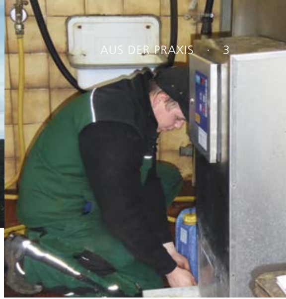
Der Profi am Werk: Wendt erneuert die Pumpe eines Kühltanks.
