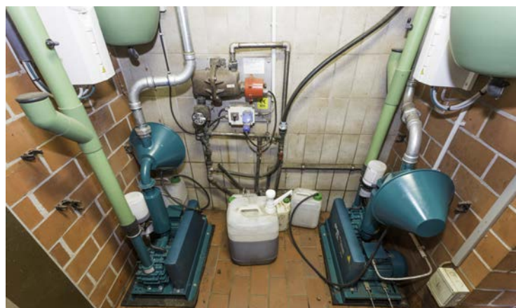
Zwei Roboter, zwei Vakuumpumpen – ein Nebenraum. Die Pumpen sind drehzahlregelt, was Energie spart. Durch den separaten Technikraum ist es beim Melken sehr leise.
