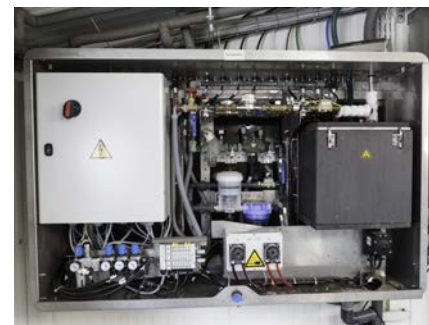
Die Versorgungseinheit mit: Reinigung, Peressigsäure- und Dippmitteldosierung, Druckluftverteilung und elektrischer Steuerung.
