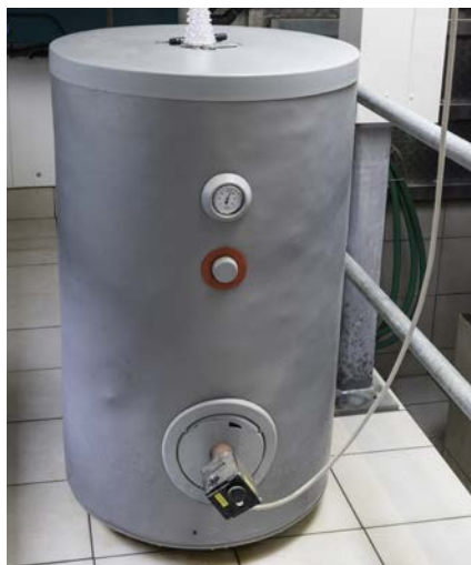
Steht normalerweise im Technikraum: Mit Hilfe eines an die Milchkühlung angeschlossenen Boilers mit Heizstab wird das 80 °C heiße Reinigungswasser aufbereitet.
